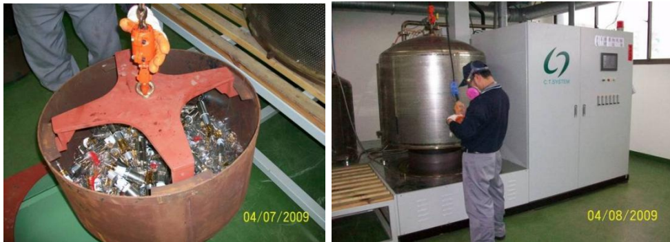
含汞廢棄物乾餾設備——進料
