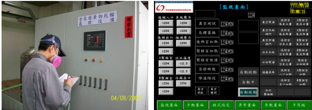
含汞廢棄物乾餾設備——控制參數紀錄
