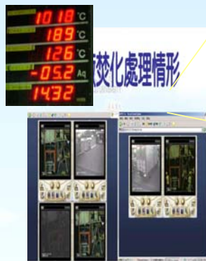
焚化爐監視系統
