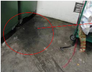
一般事業廢棄物 廢水滲出未處理
