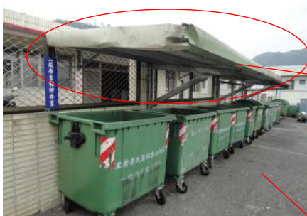
貯存區設置遮 雨棚
