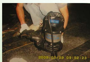
厭氣槽迴流污泥泵浦 SP-109B 安裝
