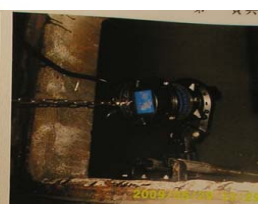
厭氣槽迴流污泥泵浦 SP-109C 安裝
