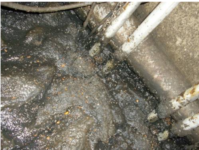
接觸曝氣池微生物死亡
