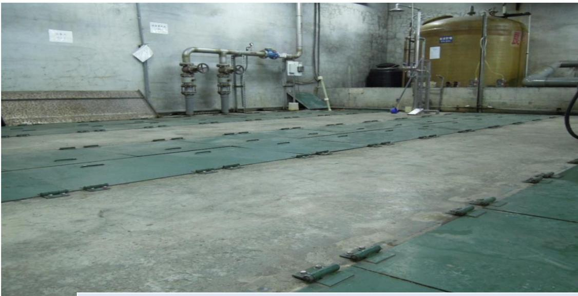
過濾後之排放水進入消毒池，以**次氯酸鈉**溶液注入消毒池消滅水中之病原菌(**大腸桿菌**)，以S型流向方式降低餘氯。
