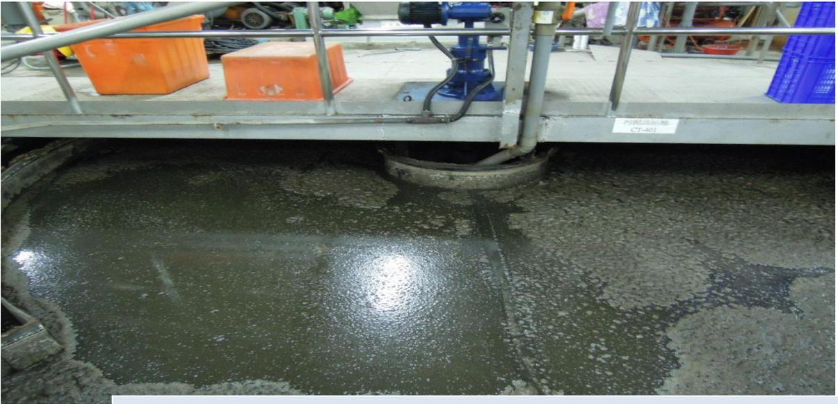
由生物反應槽中的底泥泵定期將廢棄污泥抽送至污泥濃縮池，藉由濃縮減少污泥體積，儲存污泥後再進行下一步脫水處理。
