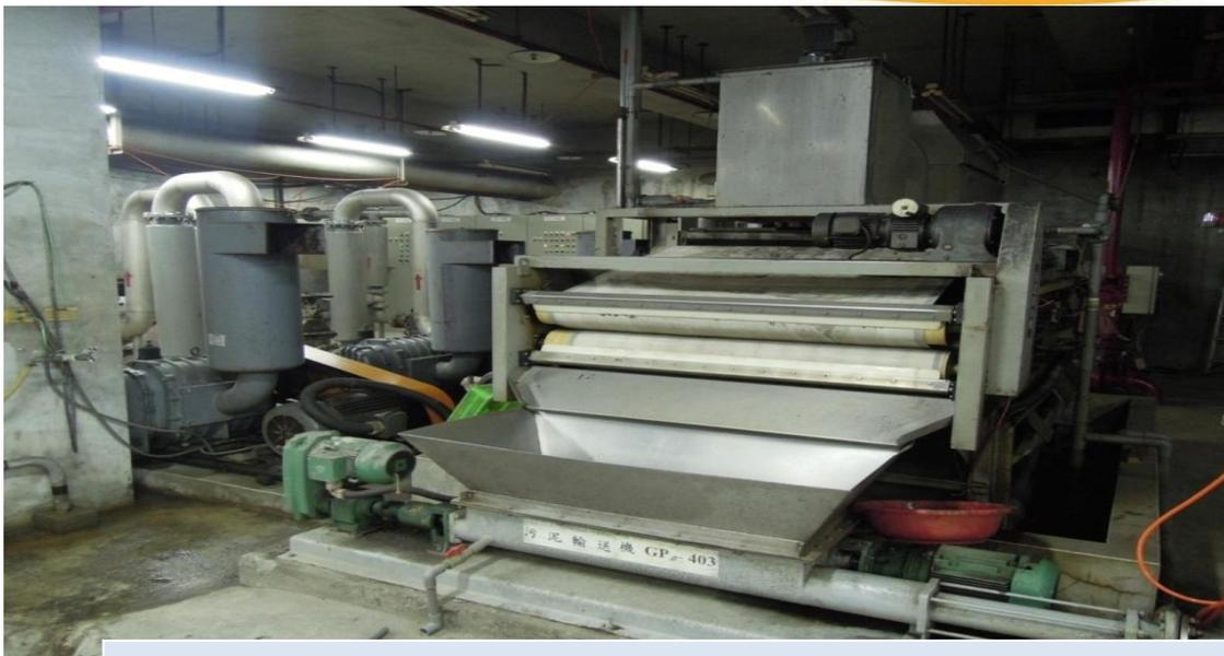
濃縮污泥加入**Polymer藥液**進行調理後進入污泥脫水機，以濾帶擠壓產生壓力脫水後形成污泥餅其污泥餅含水率不大於80%，再以污泥餅輸送設備送至廢棄物儲存槽。
