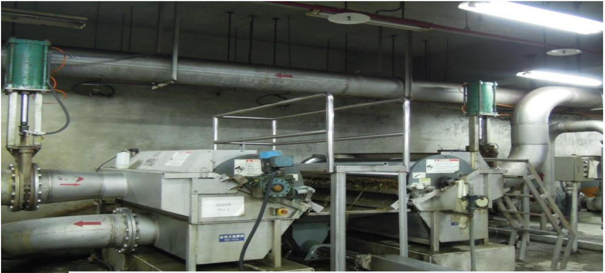
篩網機為前處理系統，經由旋轉式滾輪針對水中**大型固體物**進行去除，使原廢水適合於後續之生物處理系統，其廢水再進入均配池。
