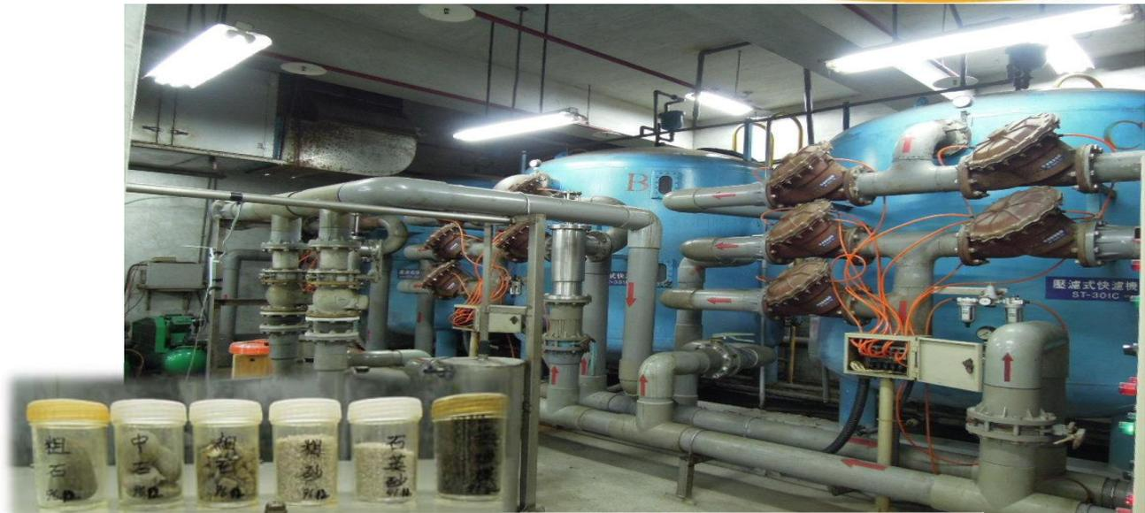
快濾機內含有由粗到細之吸附性材質，利用快濾機進流泵將廢水自緩衝池抽送至壓力式快濾機進行過濾處理，**去除水中殘留固體物**，降低懸浮固體(SS)確保放流水合於法令管制標準。
