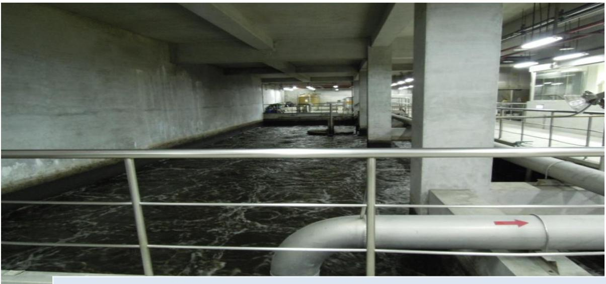
本廢水廠具兩套生物反應槽且均有預曝氣池與主曝氣池，兩套反應槽輪流進行**曝氣**、**靜置**與**排水**功能，目的為**去除原廢水中之溶解性有機污染物質**，使其化學需氧量(COD)、生化需氧量(BOD)達放流水排放標準規定。
