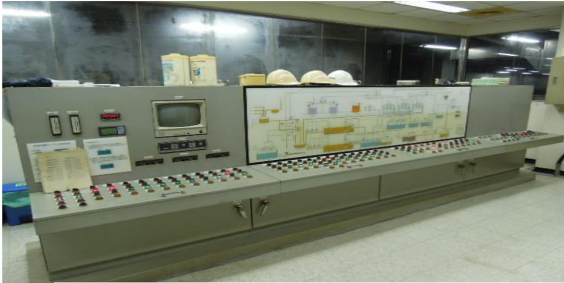
污水廠設備自動化處理，所有設備皆可由控制機台操控。
